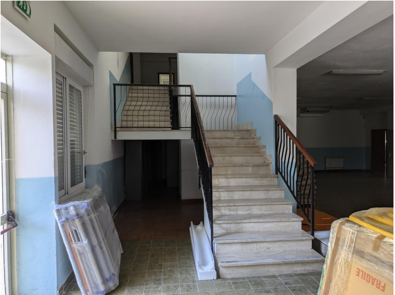
Figura 14 - attuale scala per accesso al primo livello
