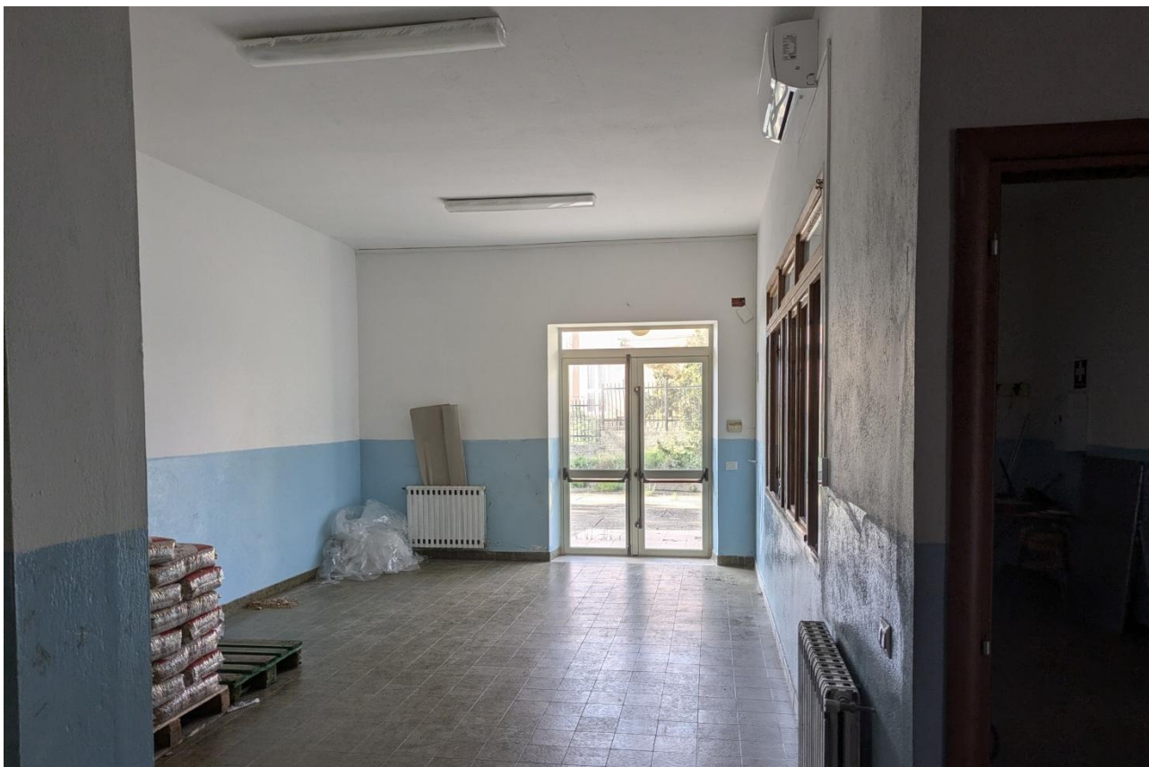
Figura 12 - vista atrio di ingresso dal prospetto Ovest
