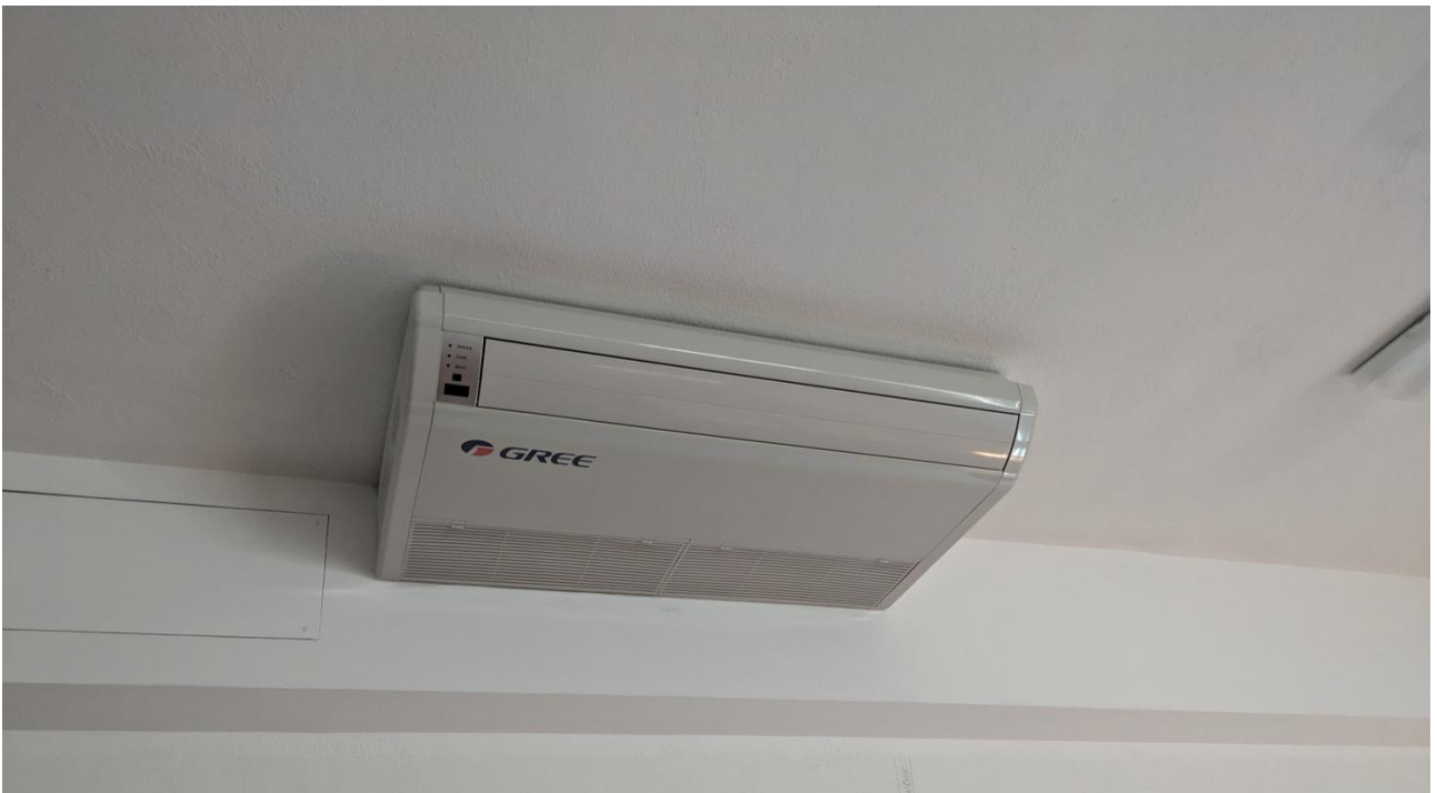
Figura 17 - ventilconvettori esistenti
