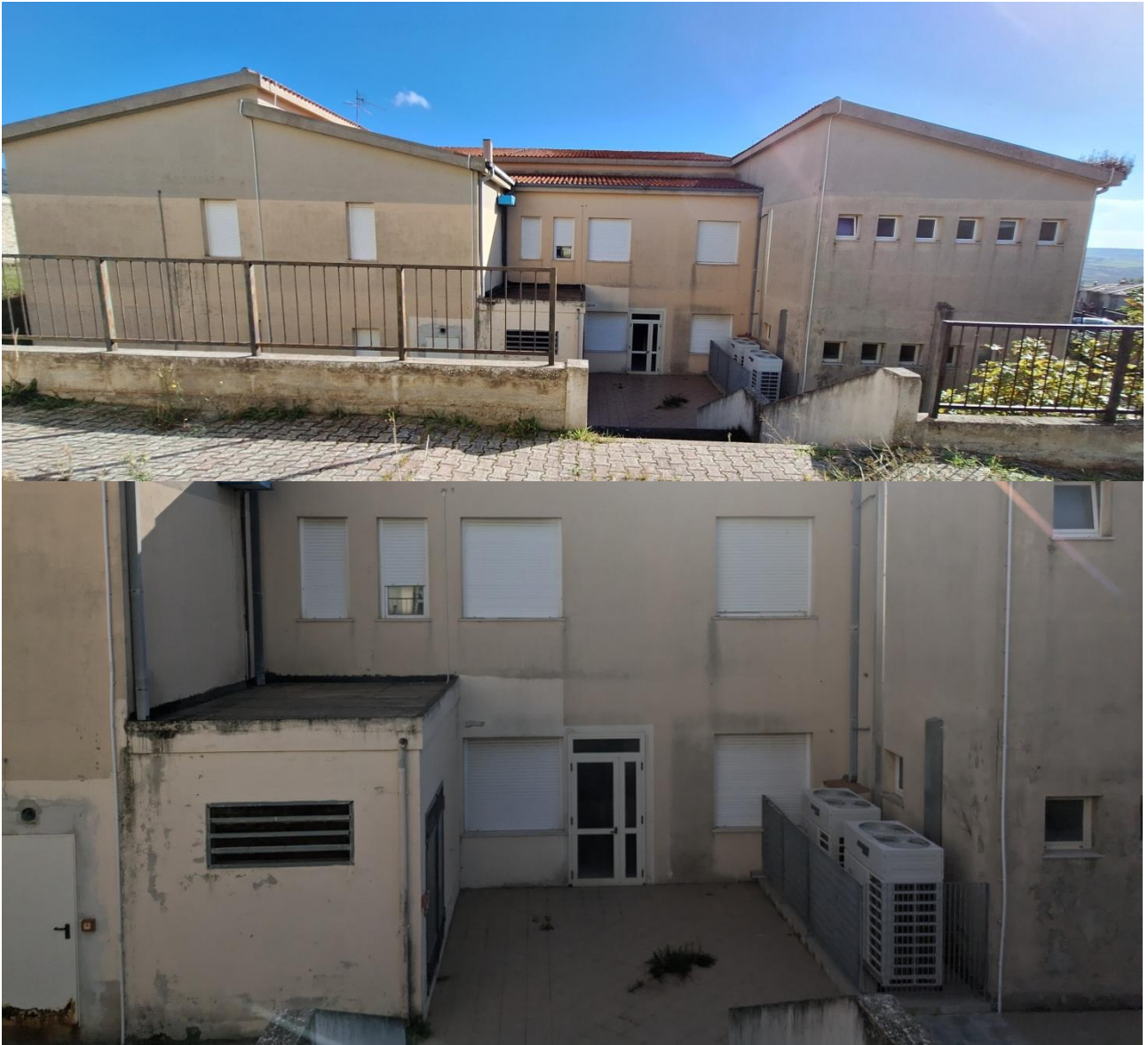
Figura 11 - Punto di visuale 3 - Prospetto Nord – vista dell'ex locale tecnico e Chiller
