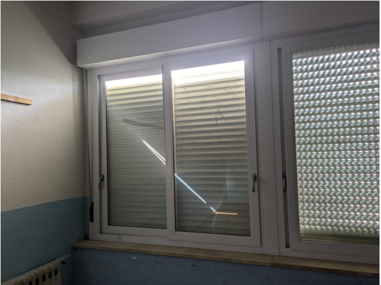
Figura 16 - tipologia infissi presenti Pvc ad ante scorrevoli
