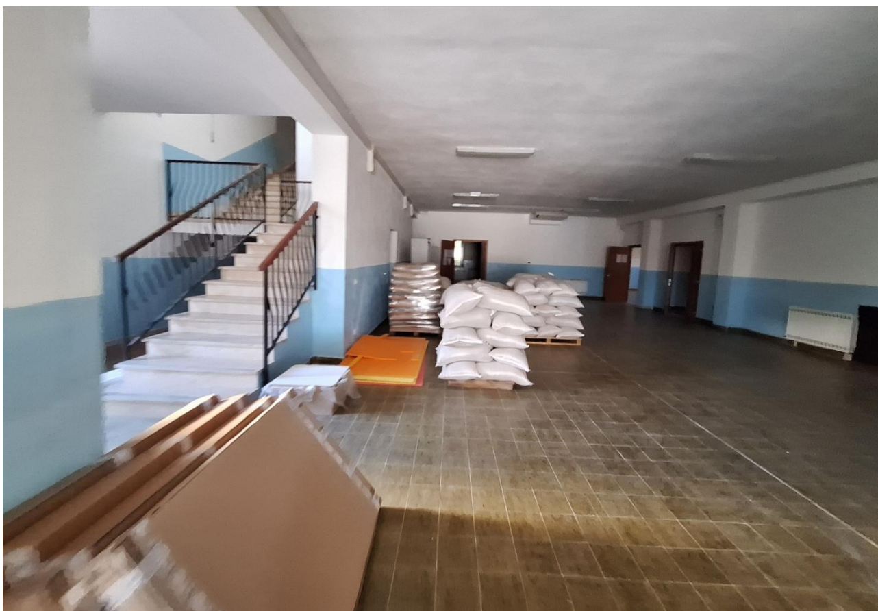
Figura 13 - vista androne di disimpegno alle aule didattiche - piano terra
